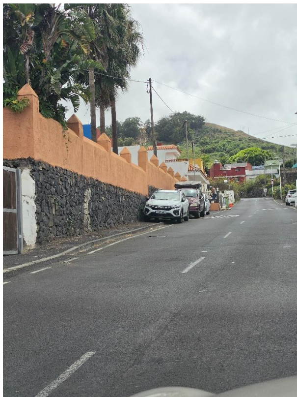
No retranquearon para dejar aparcamiento y acera
